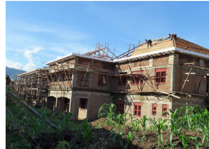
(Foto: das neue Ambulanzgebäude im April 2021)
